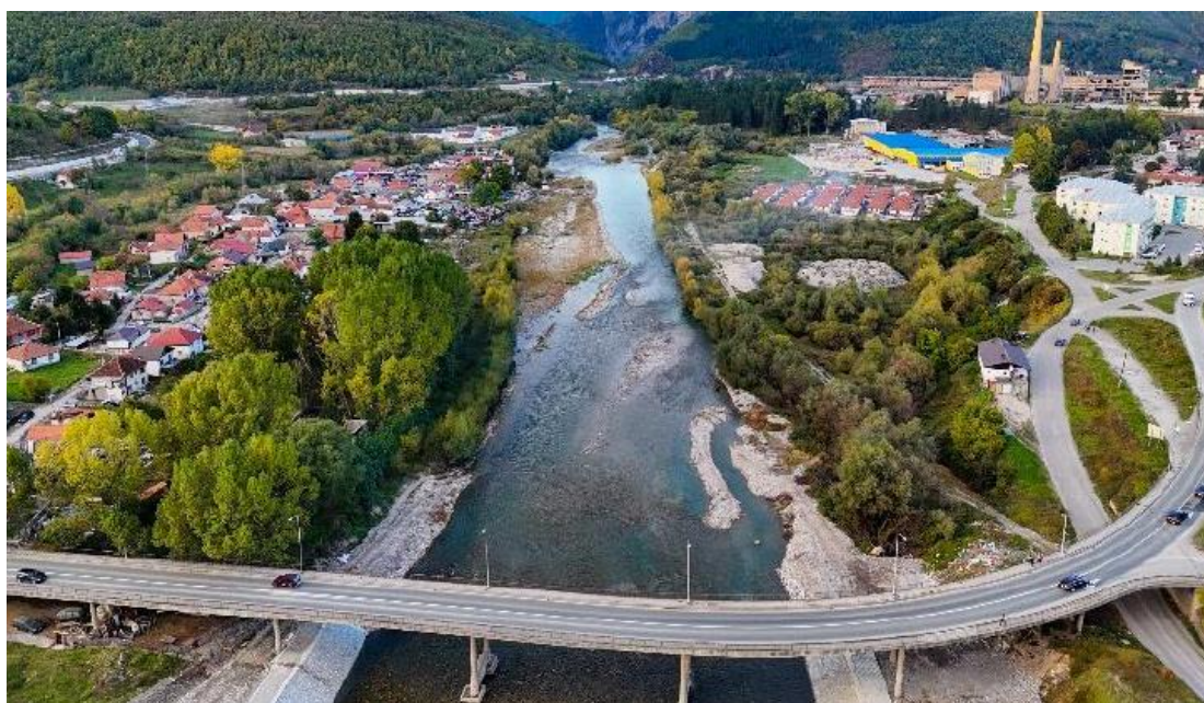
Slika 3. Izgled korita nizvodno od Talumskog mosta
