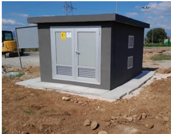
Slika br. 11. Primjer građevinskog objekta trafostanice
