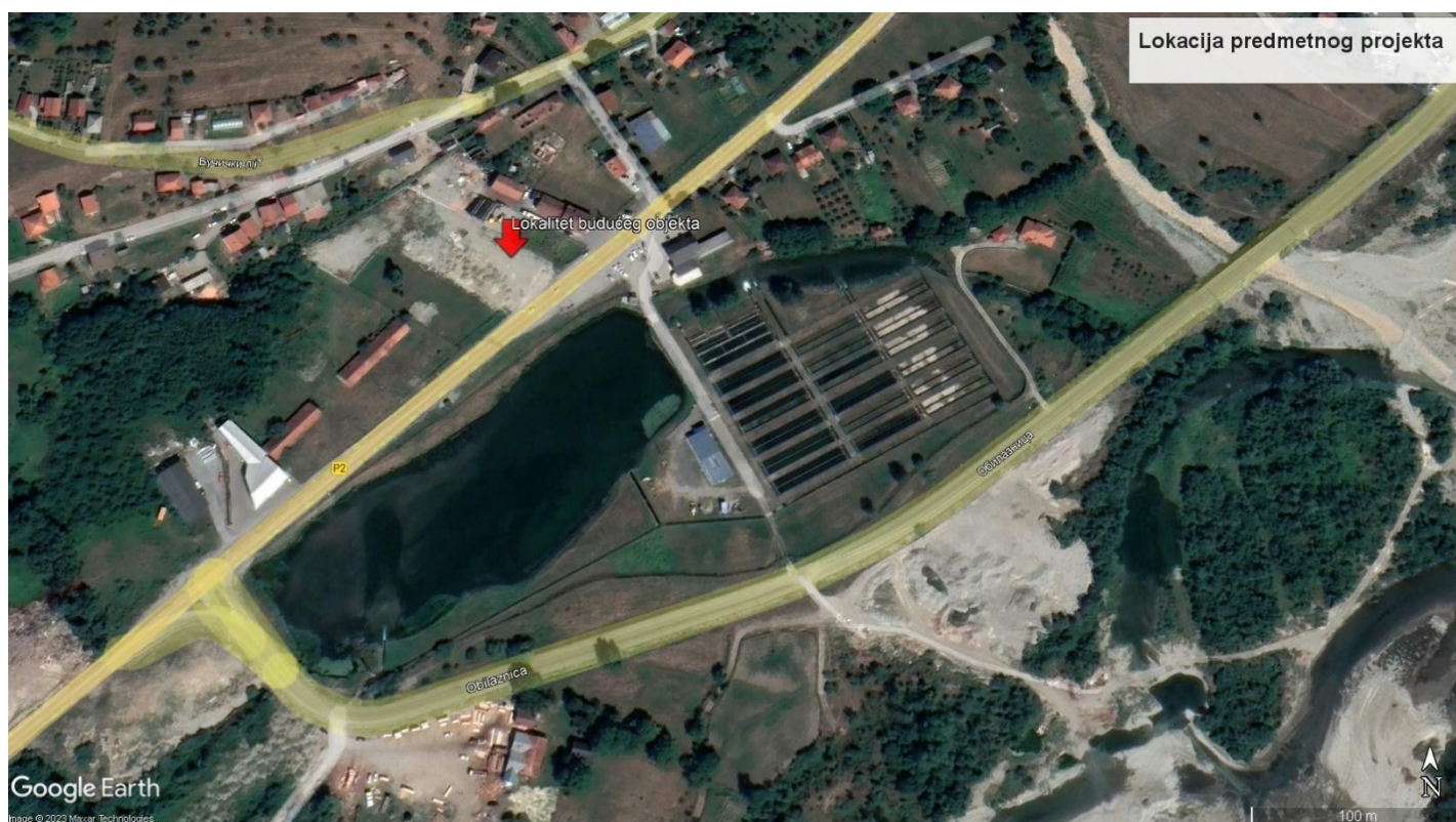
Slika 1. Položaj lokacije objekta u Beranama
